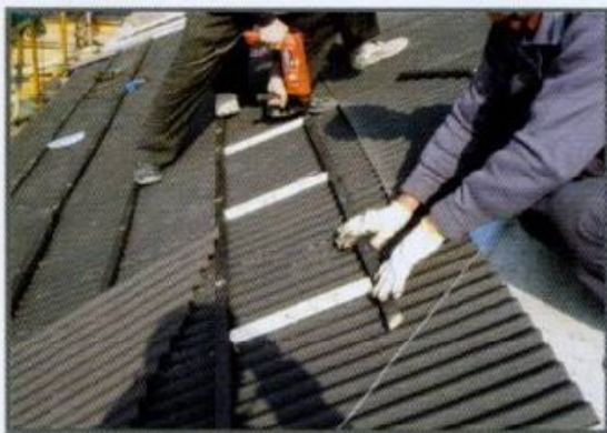
铺设波形沥青防水板
